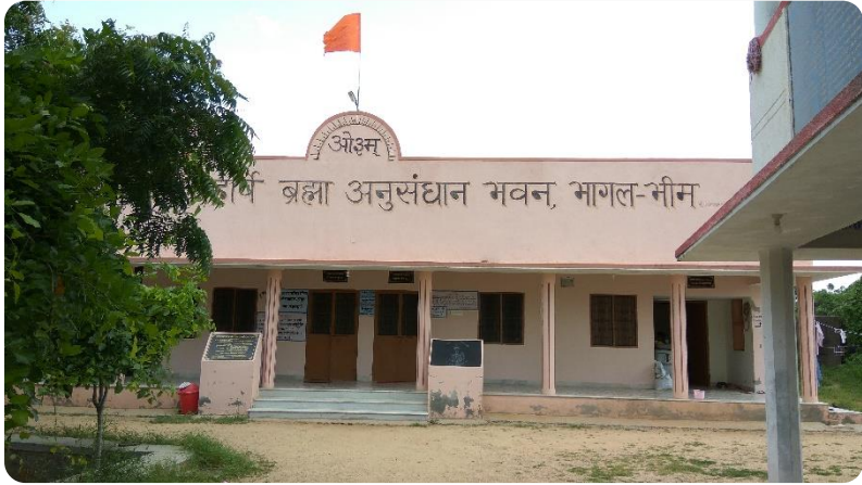
महर्षि ब्रह्मा अनुसंधान भवन
